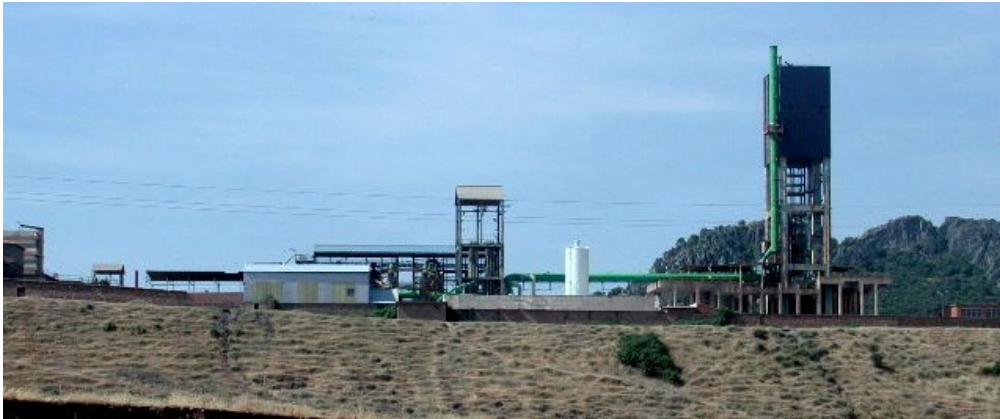
Figura 8.- El complejo minero y metalúrgico de Almadén. A la izquierda, castillete del pozo San Joaquín. En el centro, hornos de metalurgia.
