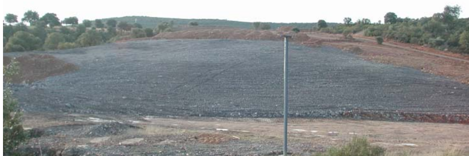
Figura 17.- Escombrera de Las Cuevas en proceso de recubrimiento.
