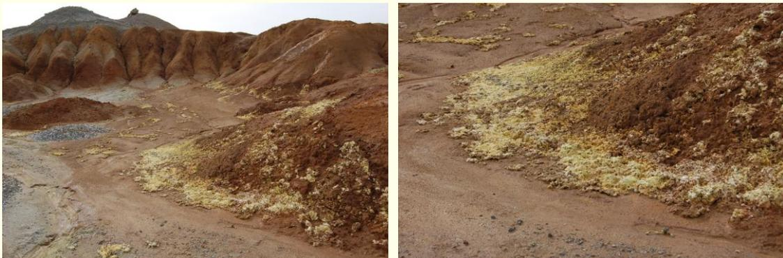
Formación de cárcavas en balsa fuertemente oxidada y formación de sales sulfatadas
